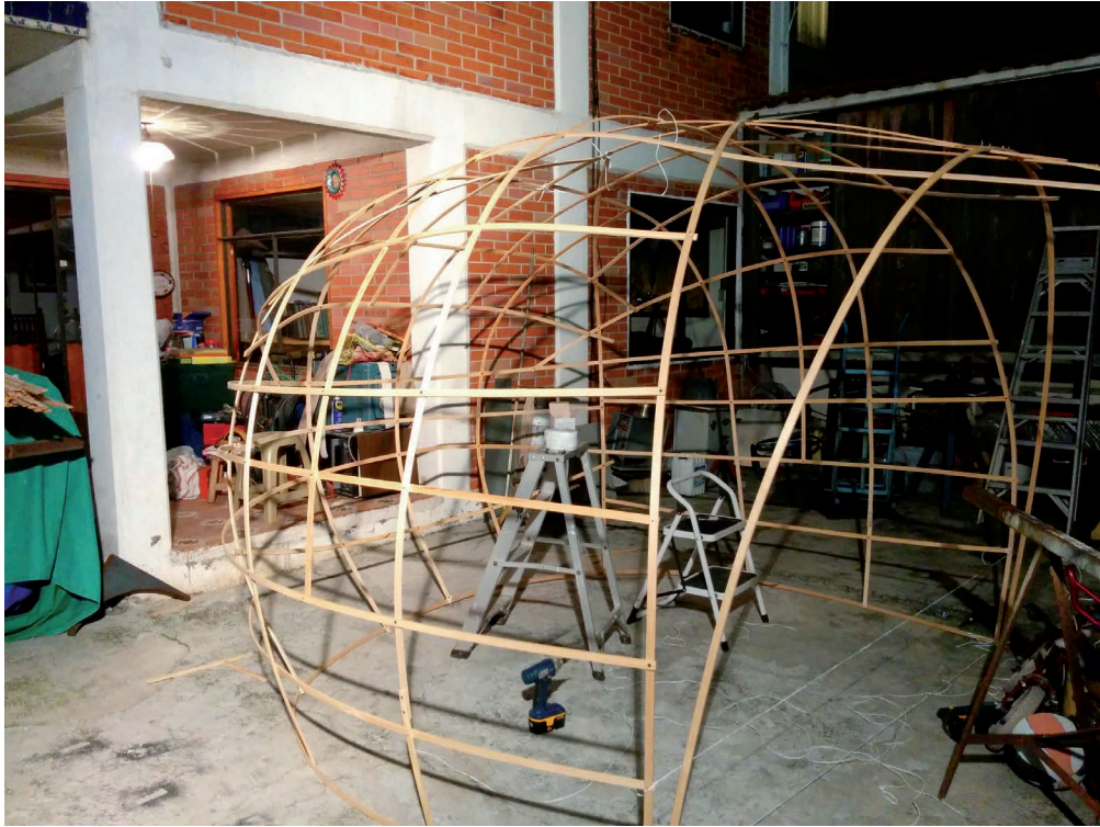
Figura 14.4. | Construcción de estructura del escuchador.
