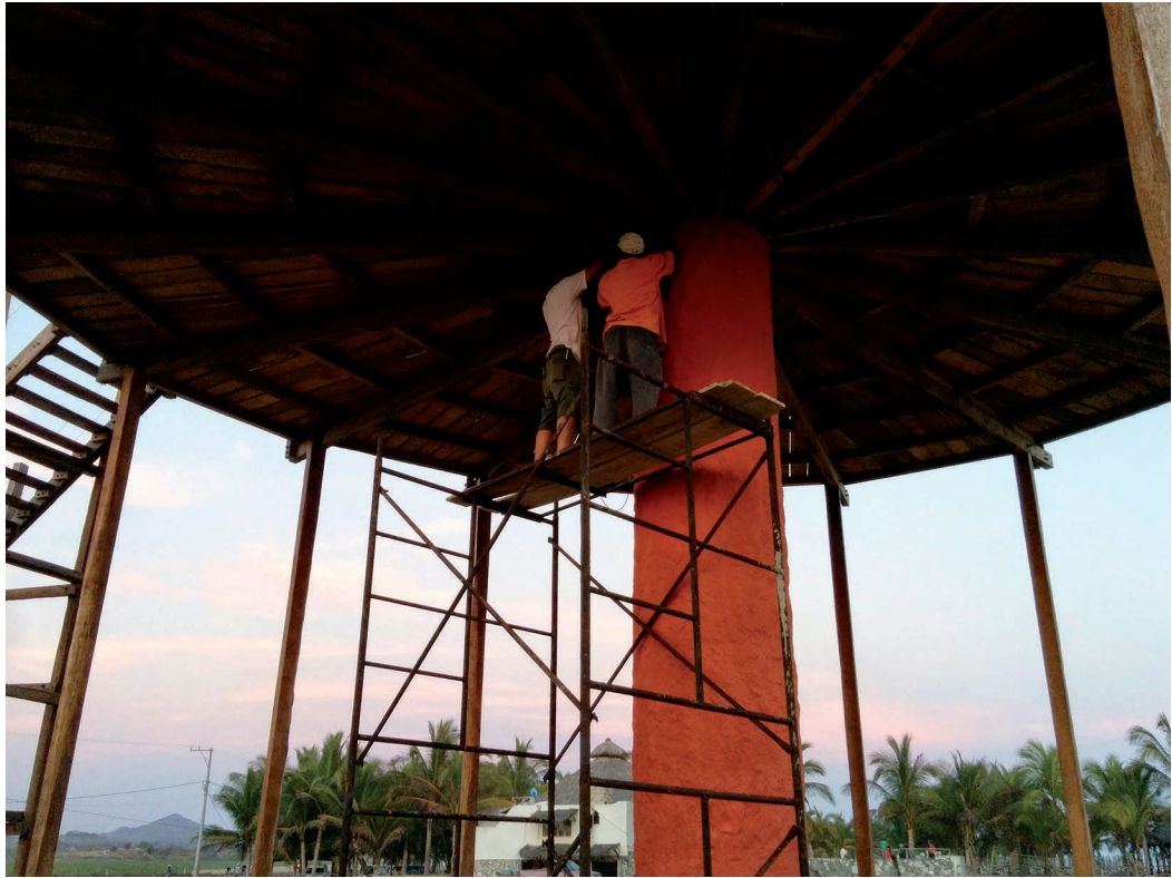
Figura 14.10. | Montaje del sistema electrónico.
