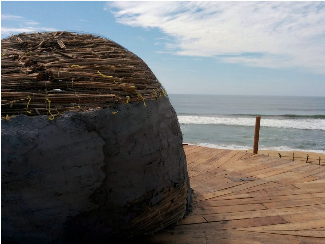
Figura 14.6. | Repellado de estructura del escuchador.
