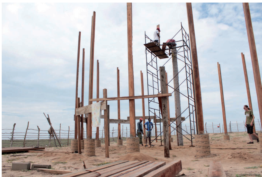
Figura 14.3. | Proceso de construcción de la estructura de Delta .
